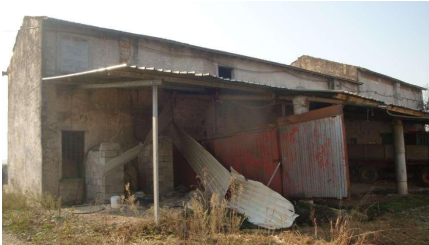
Tettoia sul retro del mapp. 871 sub. 1
