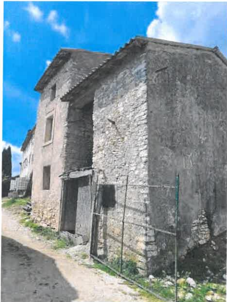
Immobile n. 3 Fg 26 mapp 644 sub 3
