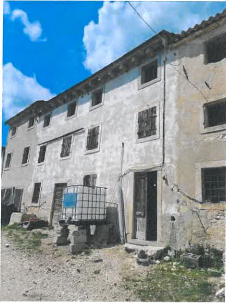
Immobile n. 1 Fg 26 mapp 644 sub 1
