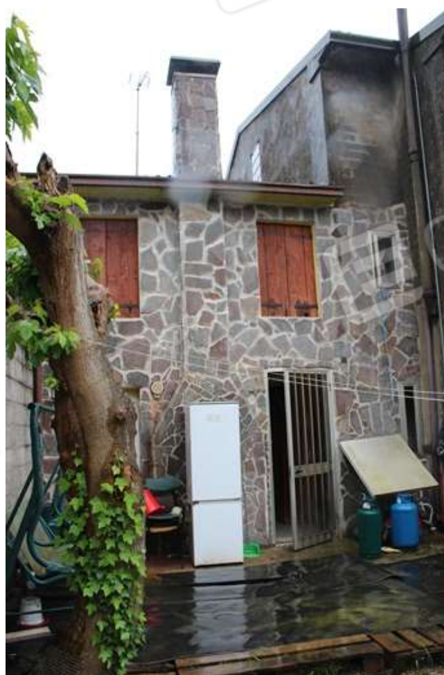
6. Facciata sul retro
