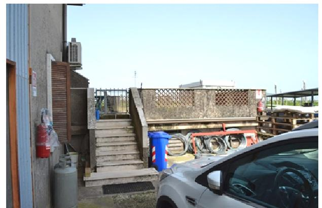
**foto 8** - m.n. 378 (terrazza) – La terrazza scoperta sul retro funge da copertura dei vani tecnici al seminterrato e, da scala, fa accedere al primo piano.
