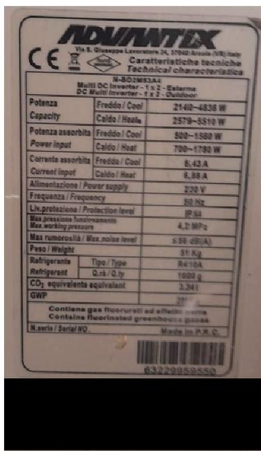
foto 16 - I valori di targa del dual split asservito all'appartamento illustrano potenze modulanti tra 2.14 e 4.84 kW in estivo e tra 2.58 e 5.51 kW in invernale.
