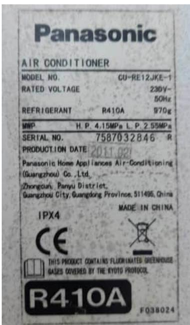
foto 15 - Lo stampigliato sulla macchina al pianterreno indica il modello e il tipo di refrigerante. Dall'01/01/2025 l'R410A non si potrà più impiegare sotto i 3 kg di carica complessiva.
