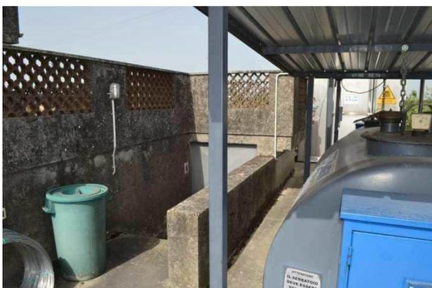
**foto 9** - m.n. 378 (pertinenze) – Sotto delle tettoie in lamiera si trovano i serbatoi di accumulo del combustibile per la c.t. (la zona non è metanizzata).
