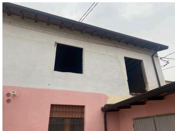
Allo stato dei luoghi non è possibile verificare l'eventuale modifica delle partizioni interne, si rileva, tuttavia, la presenza di forature esterne per finestre e porte finestre allo stato grezzo, senza serramenti o altri elementi di protezione anti-caduta.
