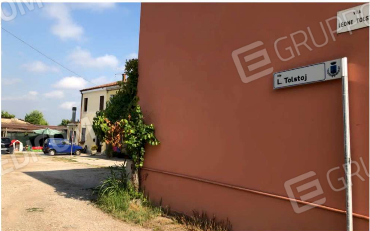
FOTO 2 - Ingresso da Via Lev Tolstoj
