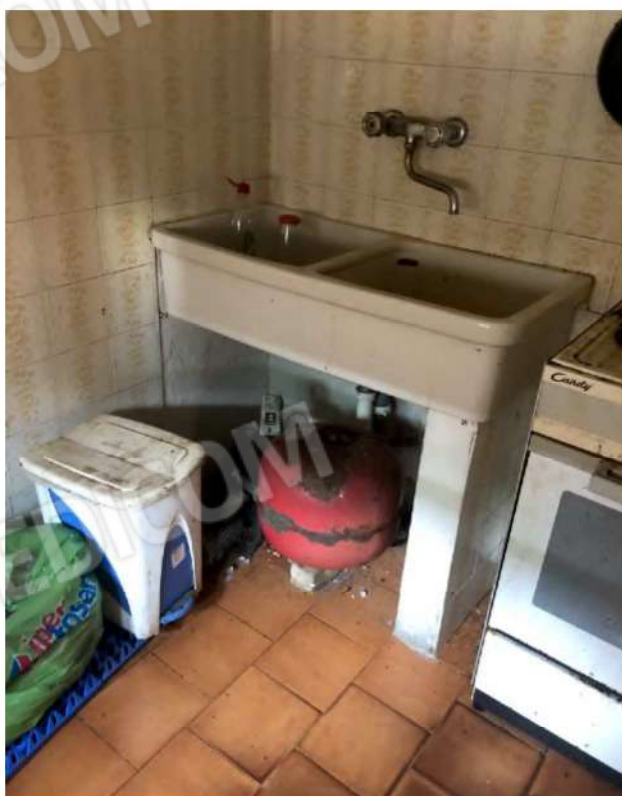
FOTO 10 - 1.a Piano terra, angolo cottura
