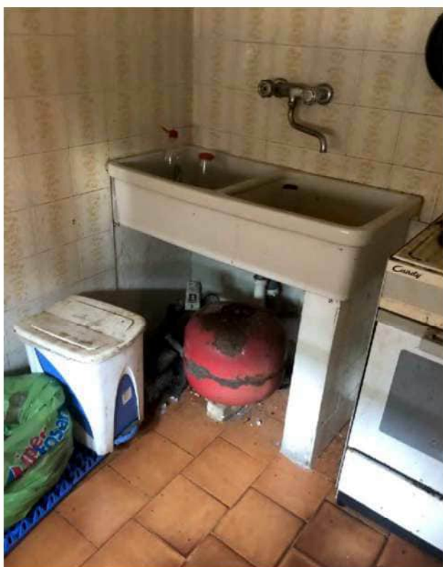
FOTO 10 - 1.a Piano terra, angolo cottura
