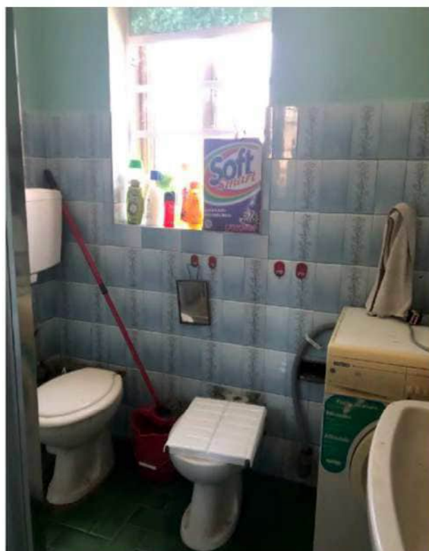
FOTO 11 - 1.a Piano terra, bagno
