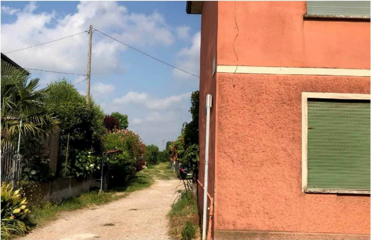
FOTO 1 - Ingresso da Via Lev Tolstoj
