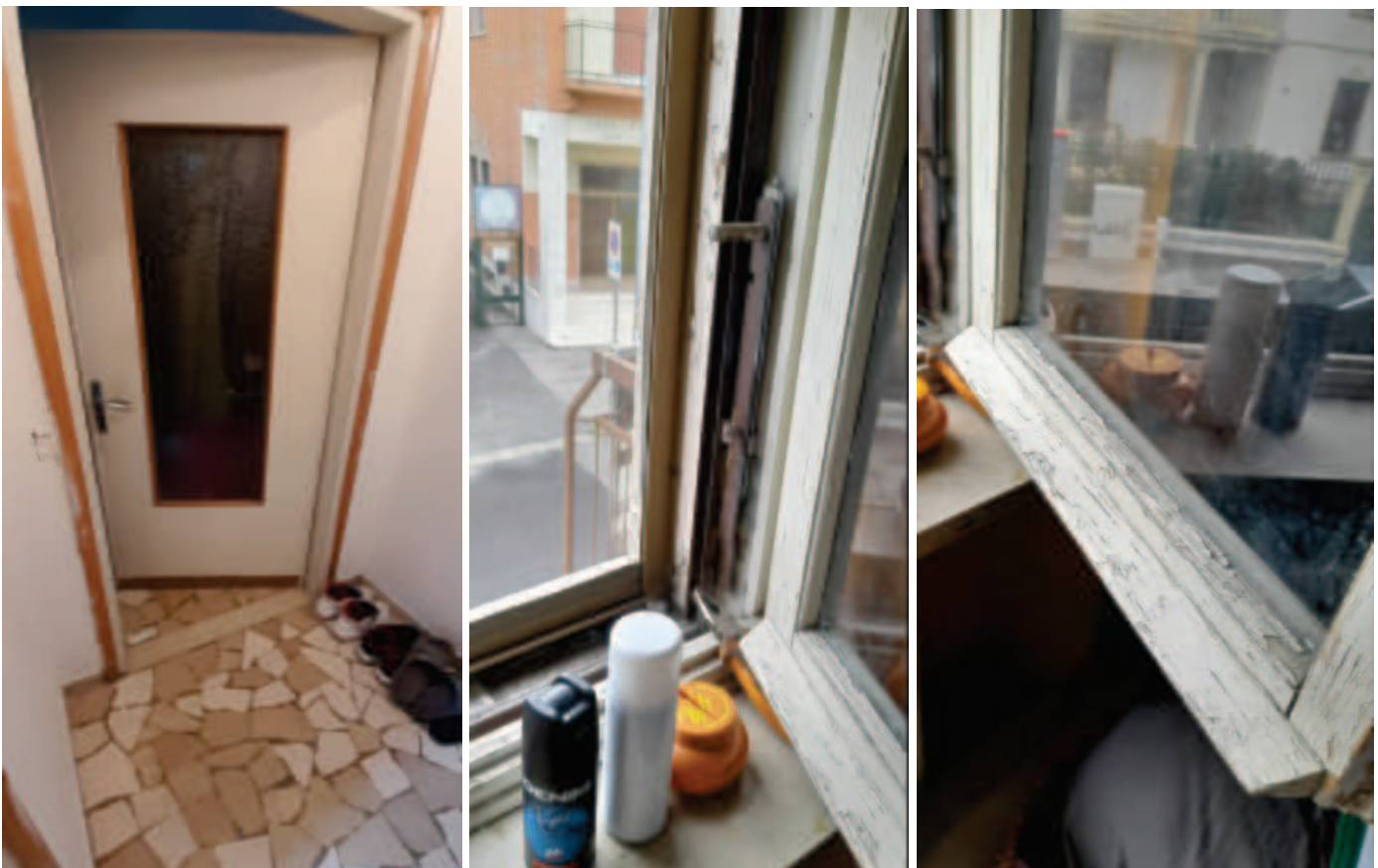
DETTAGLI DELLE FINITURE DI PORTE E FINESTRE
