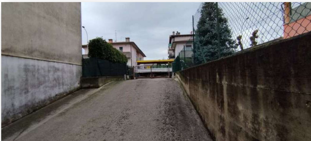
Scivolo accesso garage
