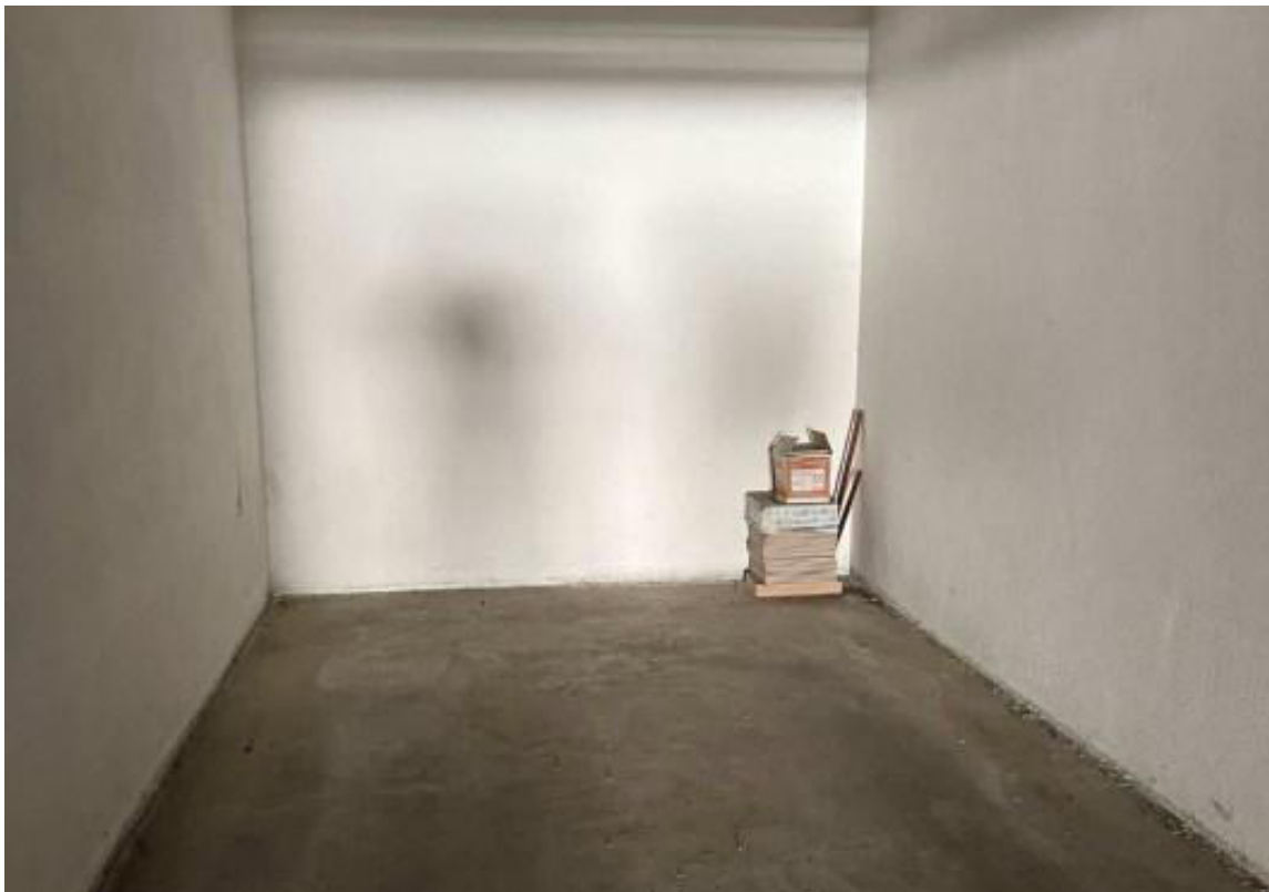
Autorimessa al piano interrato
