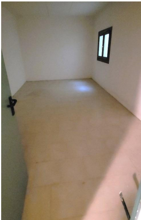
Cantina al piano interrato
