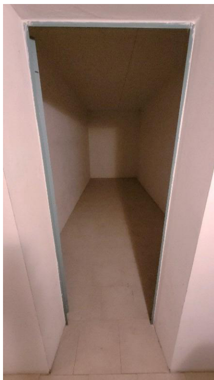
Cantina al piano interrato
