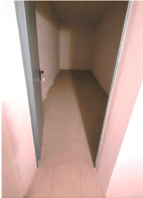
Cantina al piano interrato
