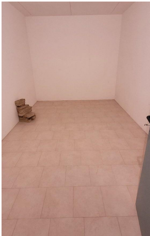
Cantina al piano interrato
