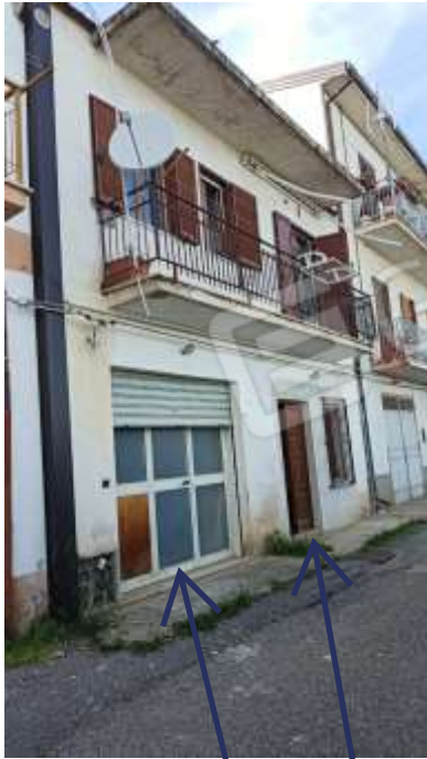
Ingresso Sub 3 e Sub 4
