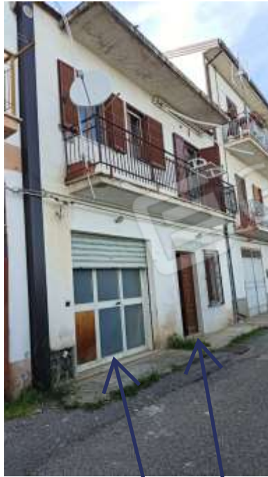
Ingresso Sub 3 e Sub 4
