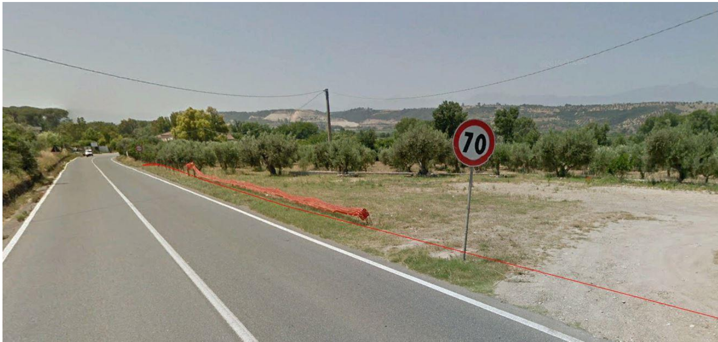
Accesso terreni corsia Sud SS 283
