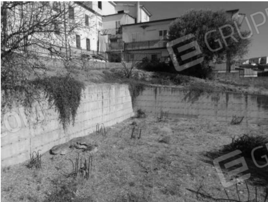
FOTO N. 14 ( p.lla 586 muro contenimento in c.a.)
