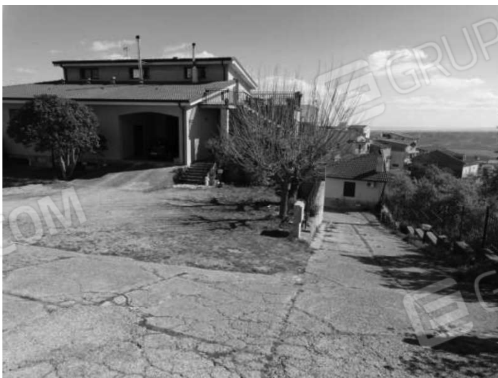
FOTO N. 10 ( p.lla 585 strada/ p.lla 655 )
