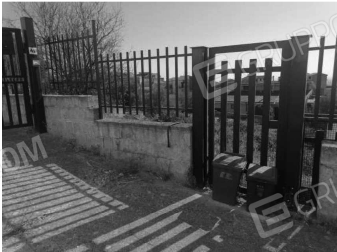
FOTO N. 7 ( p.lla 585 cancello su p.lla 586)
