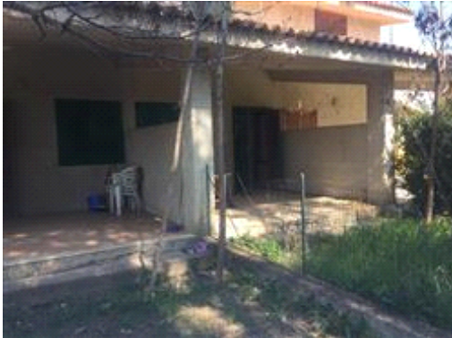
Foto sulla corte di ingresso
