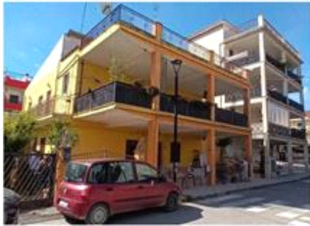
ESSEC. IMB. N° 91/2022 TRIBUNALE CASTROVILLARI - LOTTO 1 VISTA ESTERNO LATO NORD VIA CUTURA 31 LATO EST - ROCCA IMPERIALE
