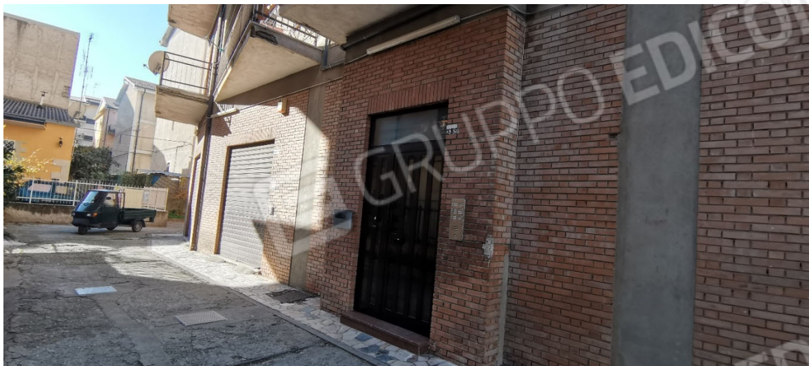
Esterno – Portone d'ingresso all'immobile in oggetto
