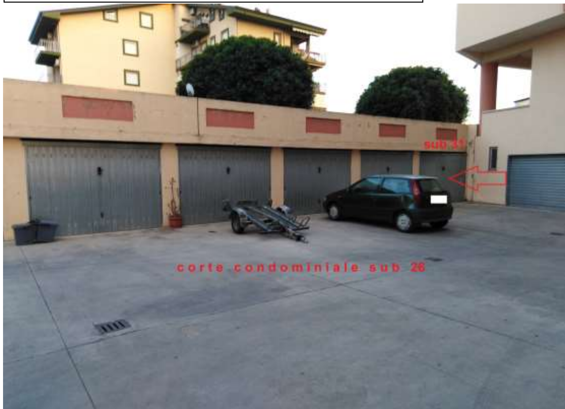
Foto n° 2 – Unità immobiliare pignorata sub 31: vista dalla corte condominiale.
