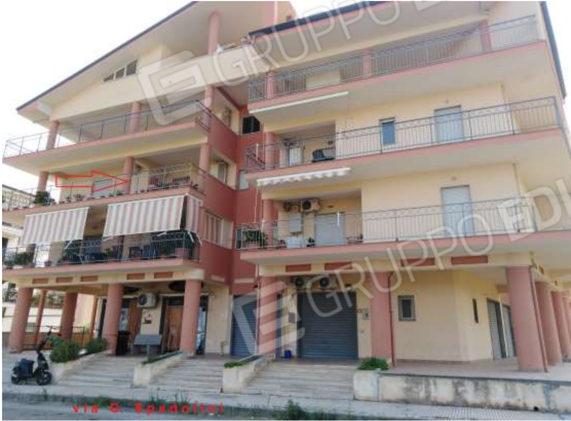
Foto n° 1 – Unità immobiliare pignorata sub 6: prospetto nord ovest.
