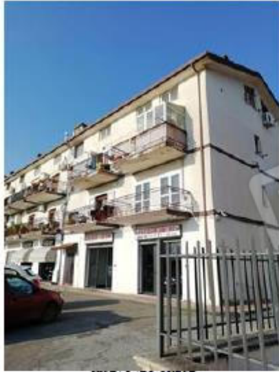
VISTA LATO OVEST
