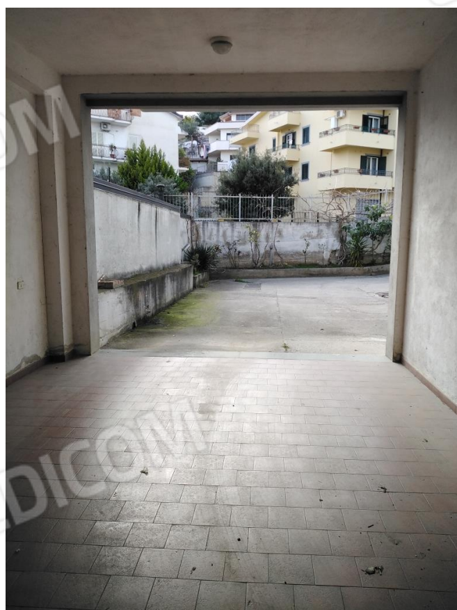
25. Ingresso piano sottostrada
