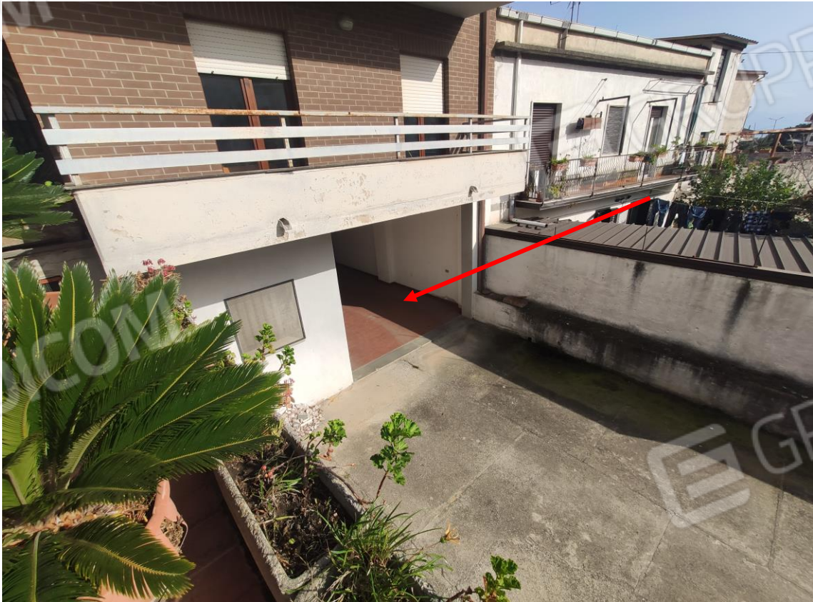
6. Veduta verso l'ingresso carrabile al piano sottostrada, magazzini, per l'accesso al Lotto 2
