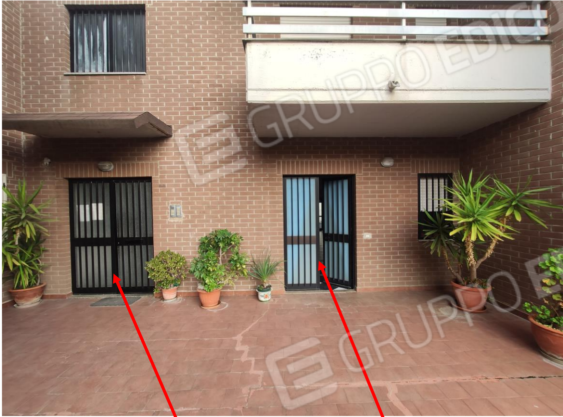
5. Veduta verso l'ingresso principale al fabbricato e verso l'ingresso usuale alla unità immobiliare pignorata
