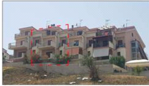
Vista generale fabbricato lato Est
