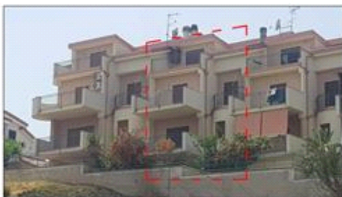
Vista esterna fabbricato lato Est
