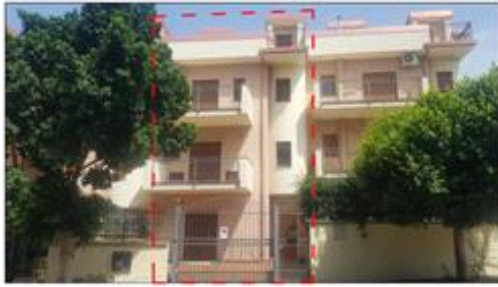
Vista esterna fabbricato lato Ovest
