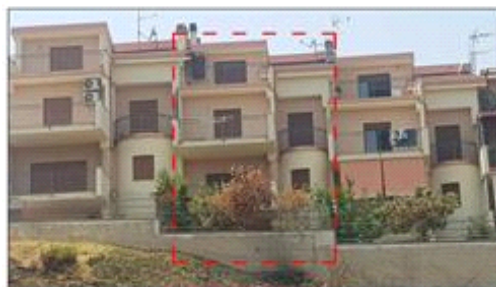
Vista esterna fabbricato lato Est
