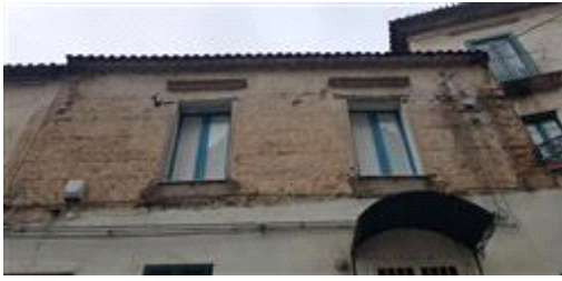
Vista esterna fabbricato lato Nord-Ovest
