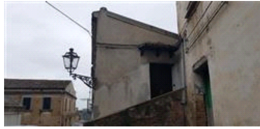
Vista esterna fabbricato lato Sud-Ovest
