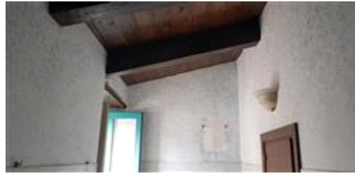
Vista interna dell'abitazione (nel bagno) da cui si rileva il nuovo solaio di copertura e l'assenza del solaio di sottotetto
