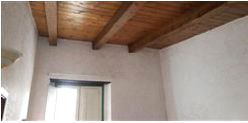
Vista interna dell'abitazione (nella camera da letto) da cui si rileva il nuovo solaio di copertura e l'assenza del solaio di sottotetto
