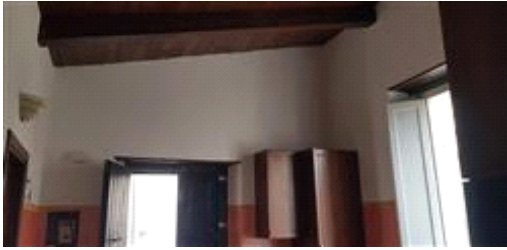
Vista interna dell'abitazione (nella cucina) da cui si rileva il nuovo solaio di copertura e l'assenza del solaio di sottotetto
