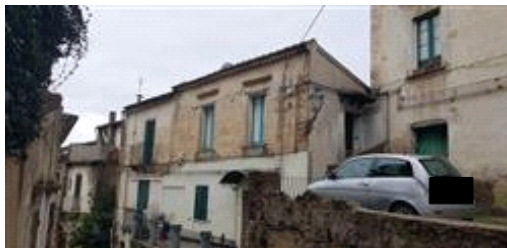
Vista generale fabbricato lato Nord-Ovest e Sud-Ovest
