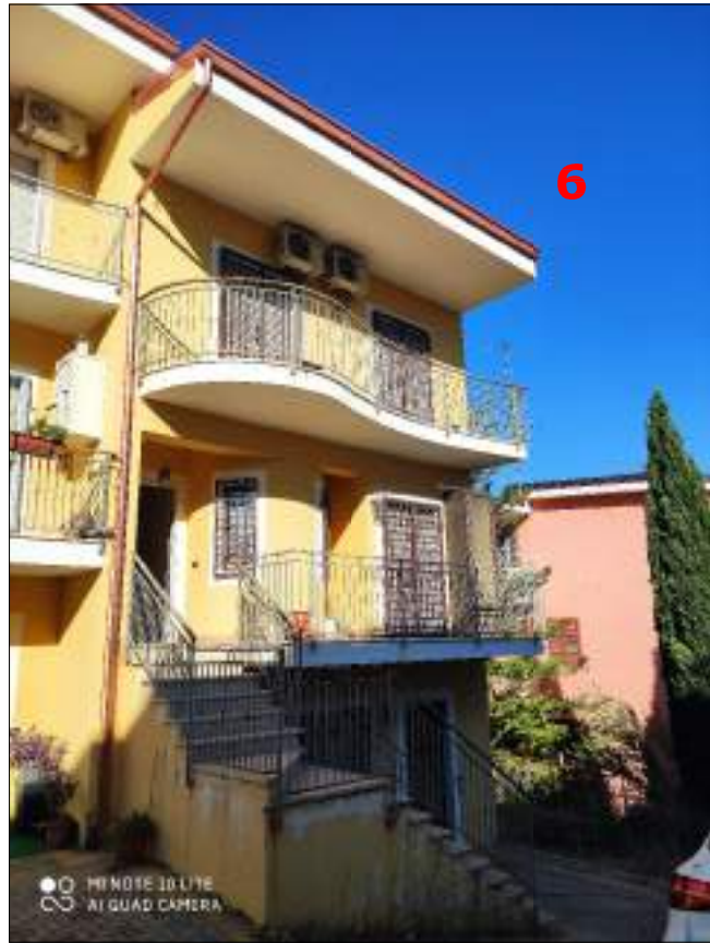
FOTO 6 - Vista frontale lato ingresso
