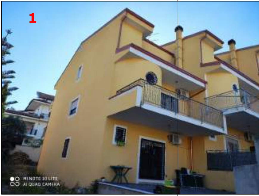
FOTO 1 - Vista esterna del fronte posteriore
