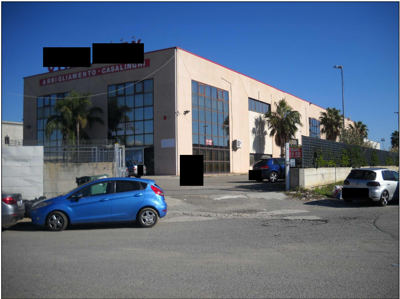
Foto 15: L'ingresso al compendio immobiliare
