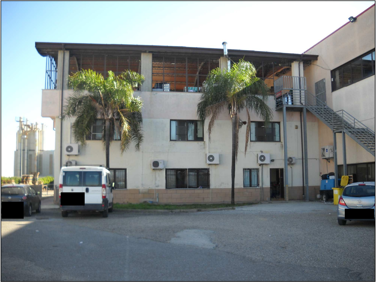
Foto 13: La facciata principale
