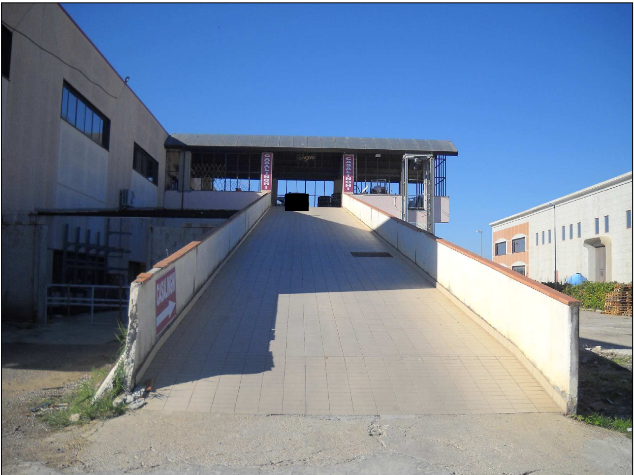
Foto 14: La rampa di accesso al terrazzo
