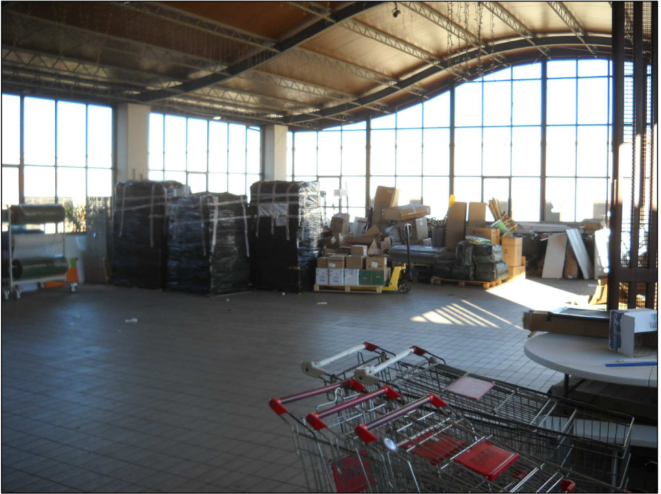
Foto 9: Interno Palazzina Uffici Piano Primo (Terrazzo)
