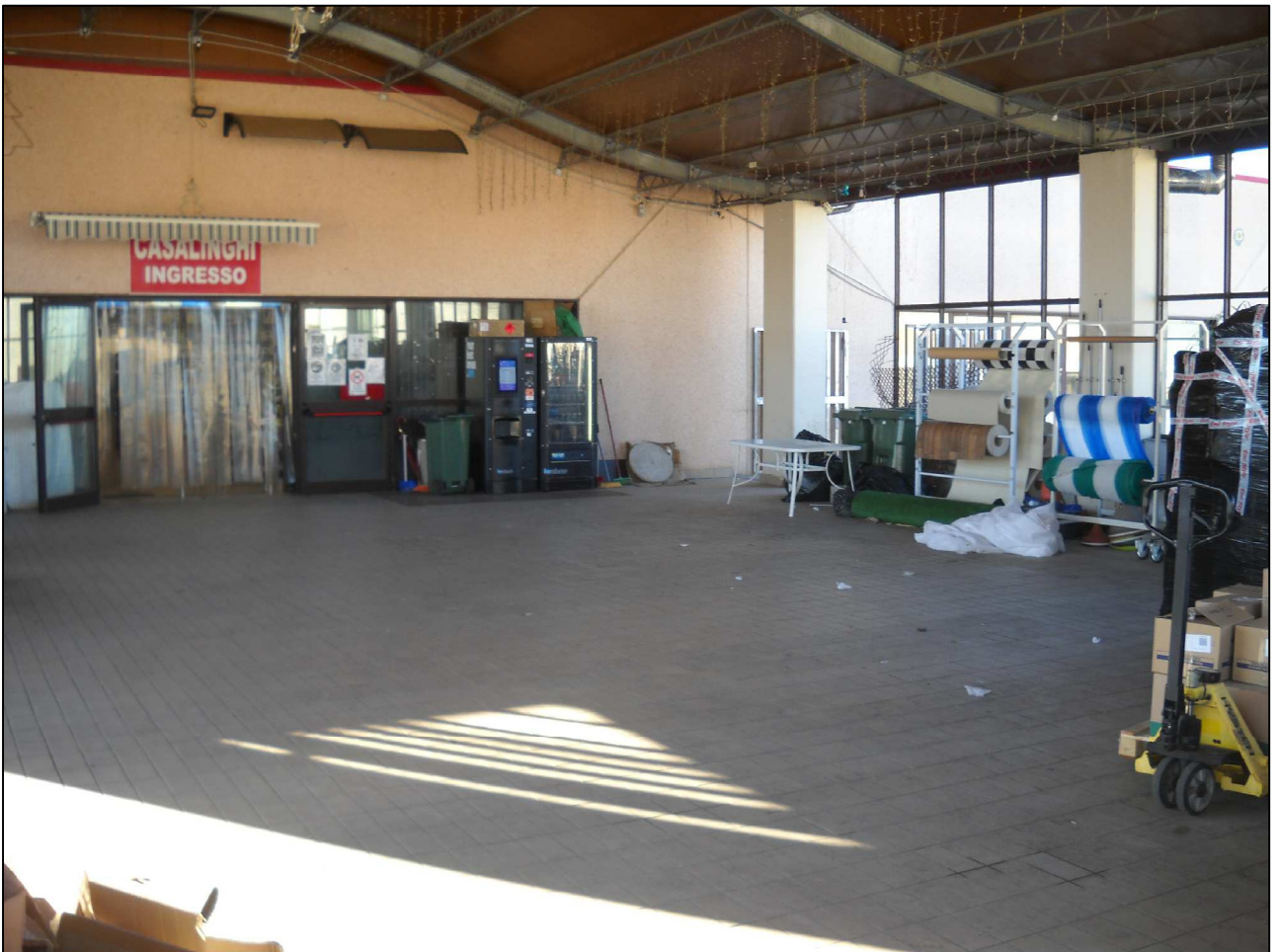
Foto 10: Interno Palazzina Uffici Piano Primo
