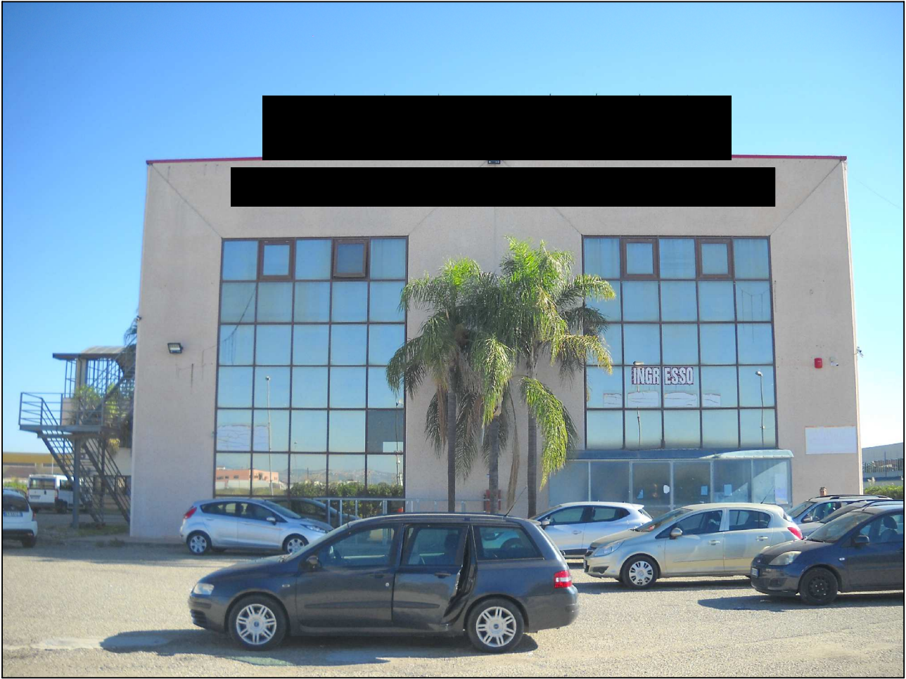
Foto 11: La facciata principale
