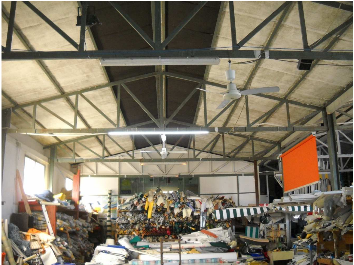
La struttura in acciaio (pilastri – capriate – profilati)
