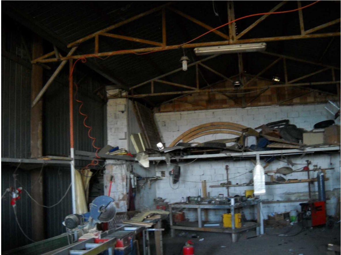
La struttura in acciaio (pilastri - capriate - profilati)
