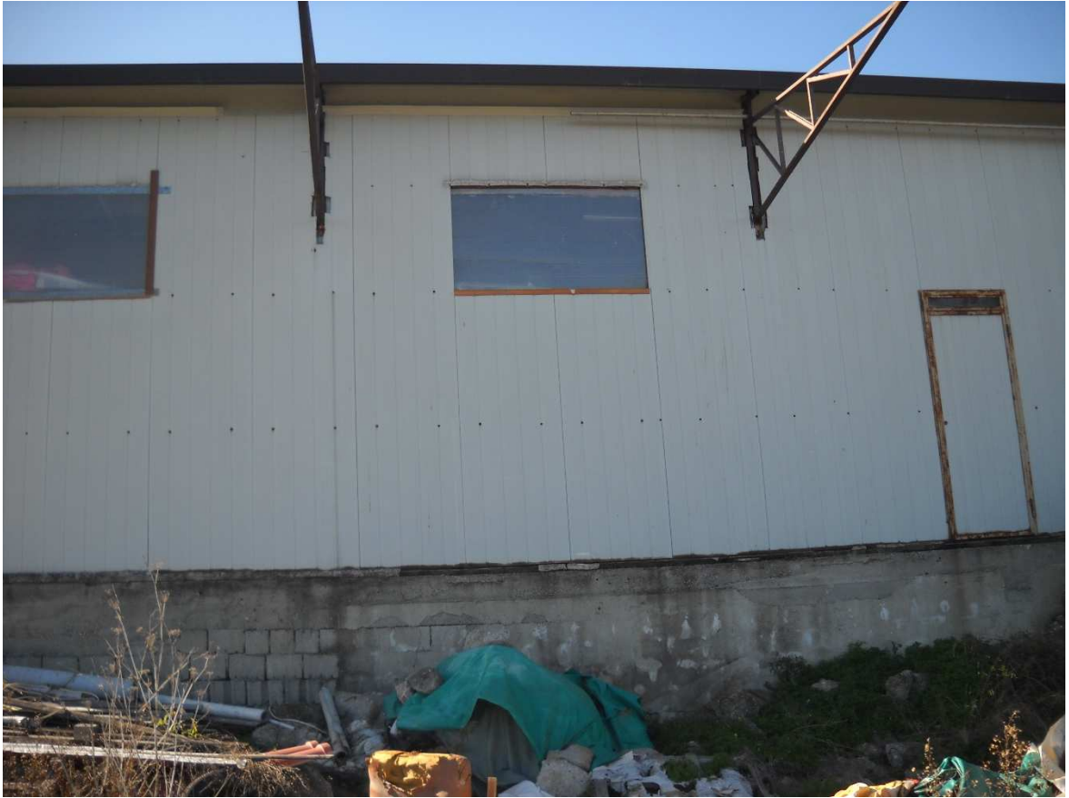
La fondazione (cordolo in c.a. che poggia su muretto in blocchi di cemento)
