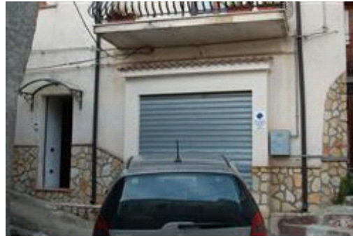
ingresso secondario e porta magazzino
