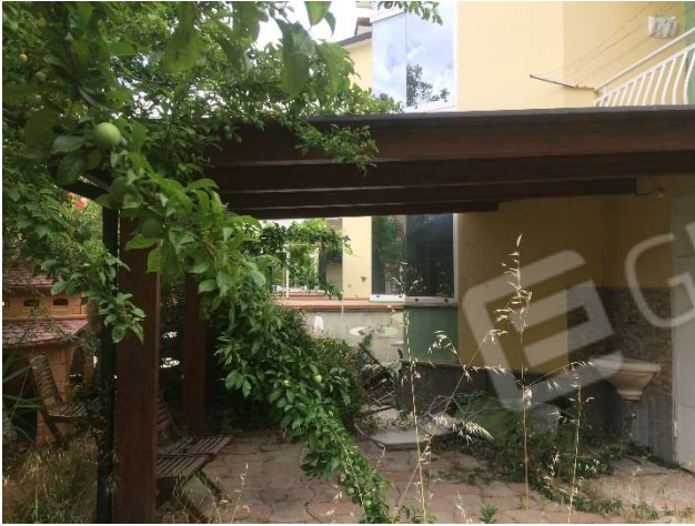
Particolare corte con tettoia
