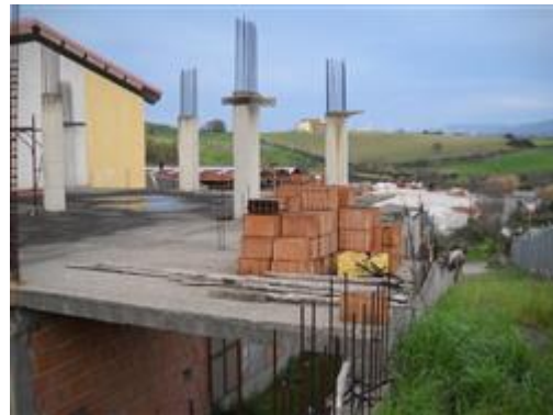
piano primo lastrico solare
