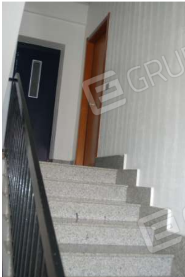
corpo scala condominiale
