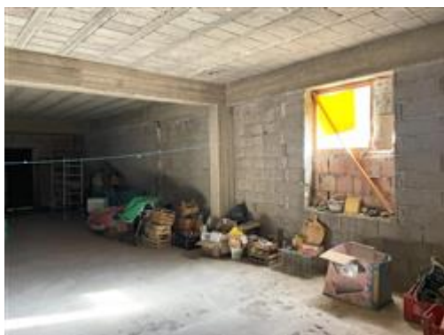
Porzione in corso di definizione
