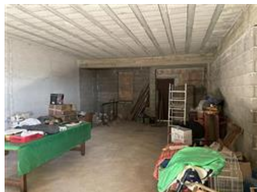
Porzione in corso di definizione
