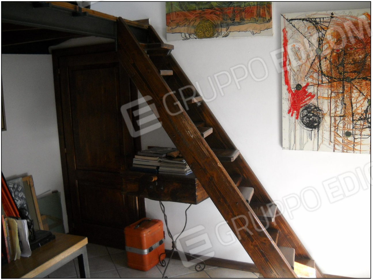
Foto 5: La scala alla marinara
