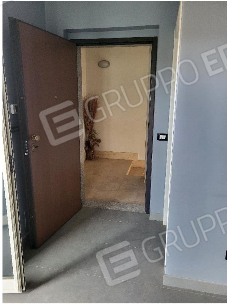
FOTO 9 - Portone ingresso appartamento
