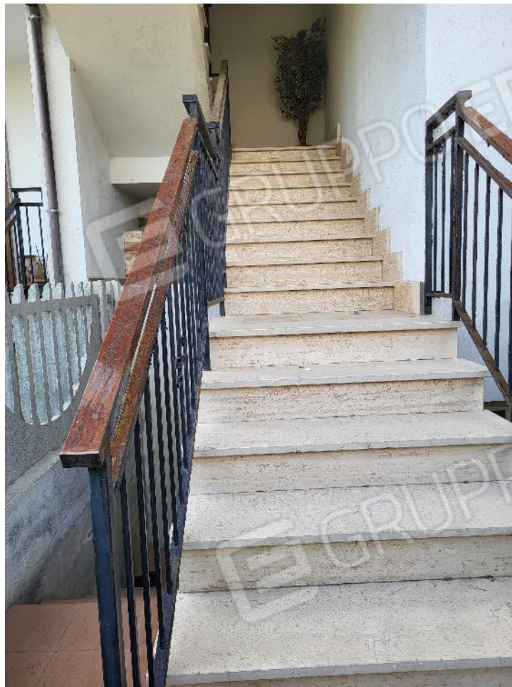
FOTO 7 - Scale accesso appartamento
