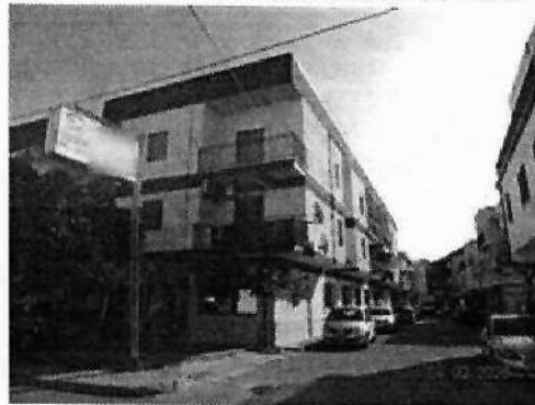
Foto esterni fabbricato
