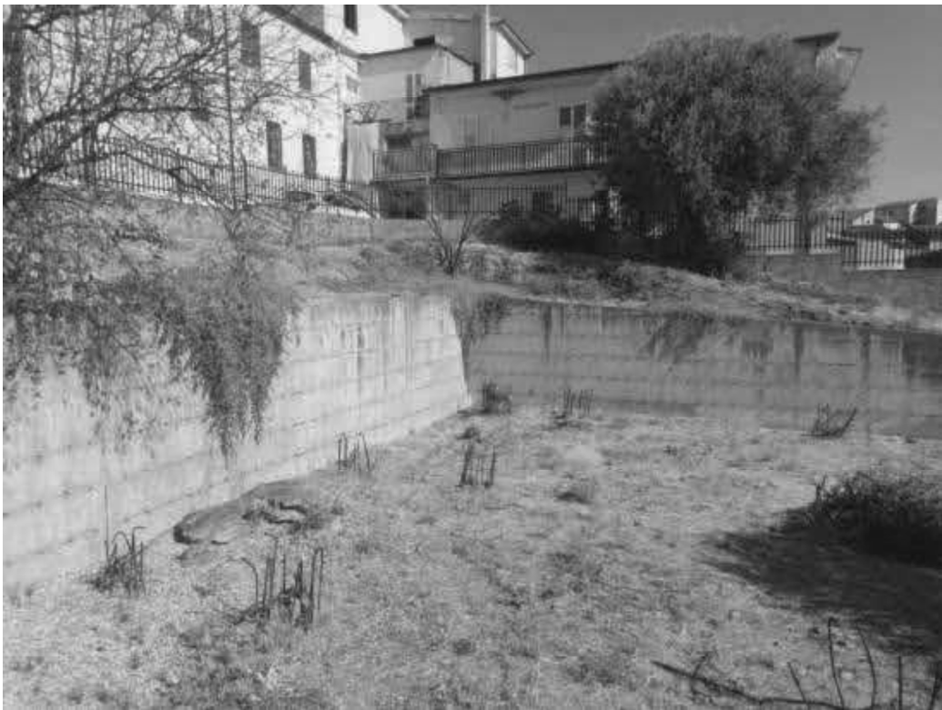
FOTO N. 14 ( p.lla 586 muro contenimento in c.a.)
