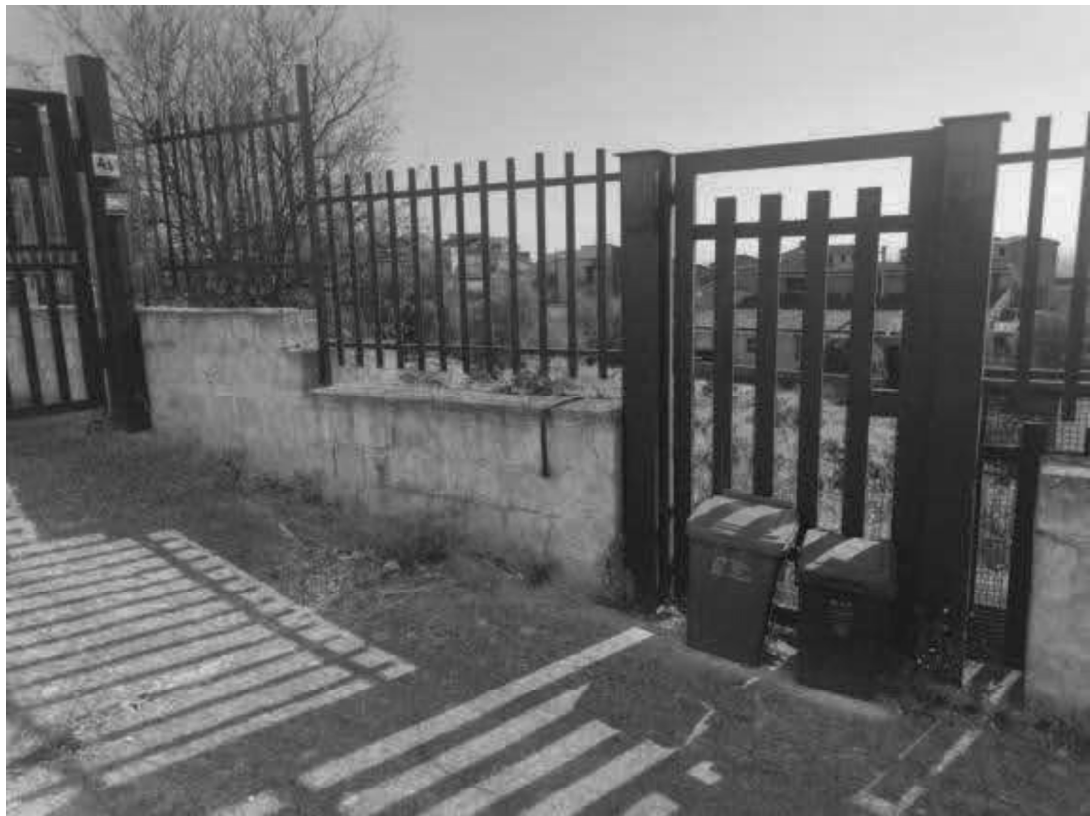
FOTO N. 7 ( p.lla 585 cancello su p.lla 586)
