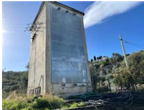
CABINA ELETTRICA SUB.3
