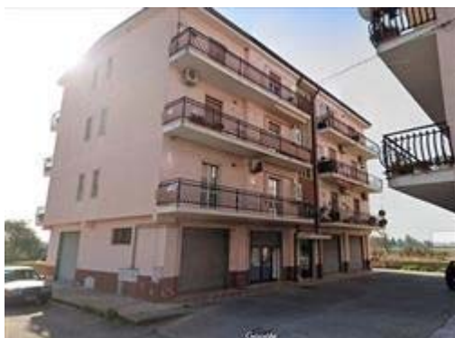
palazzina in oggetto
