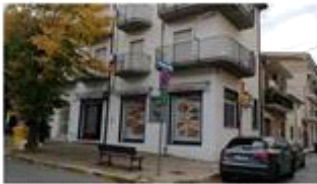
Foto del fabbricato
