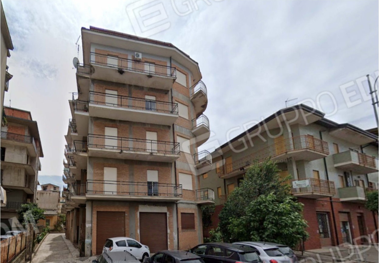
Esterno – Fabbricato di cui fa parte l'immobile in oggetto
