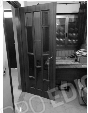
vano pluriuso p.Terra Particolare porta e infissi
