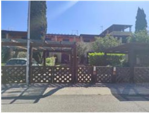
Veduta prospetto Ovest
