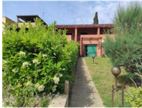
Veduta prospetto Est
