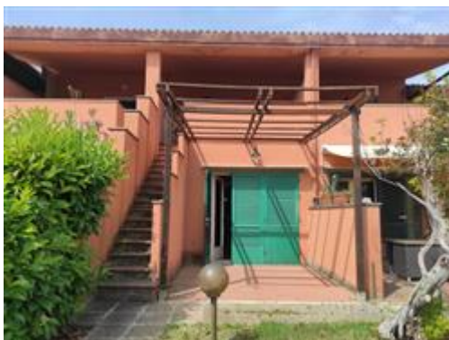
Particolare prospetto Est
