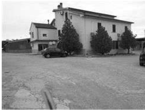
vista d'insieme del fabbricato costituito dai lotti n. 1, 2, 3 part. n.
