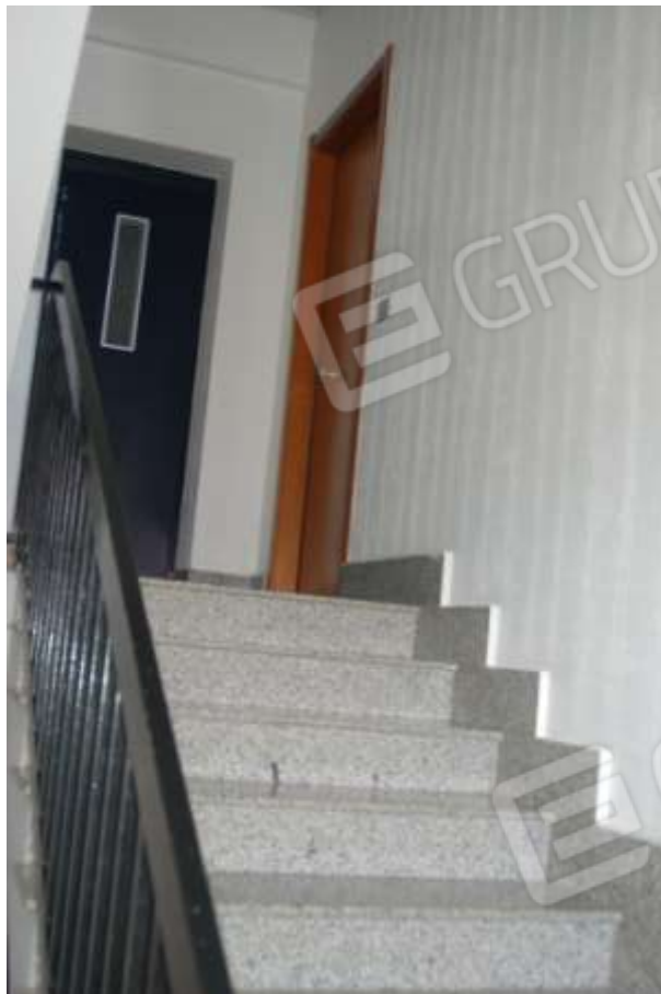
corpo scala condominiale
