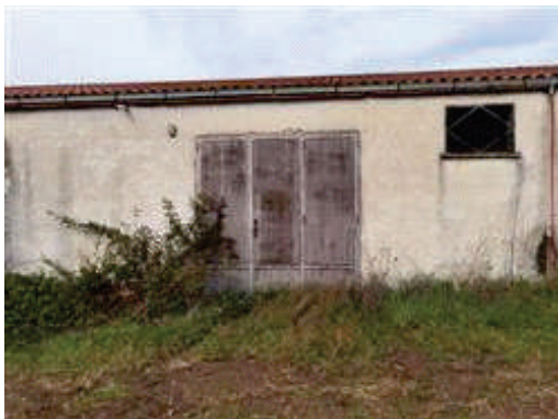
Foto Esterni - Ingresso
