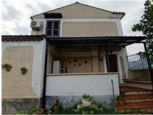
Tettoia ed ampliamento di volume e superficie senza titoli autorizzativi
