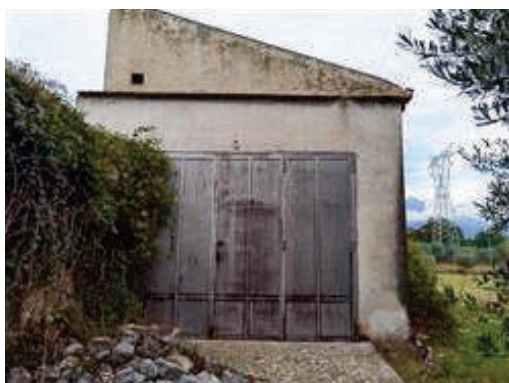
Foto esterni - Ingresso
