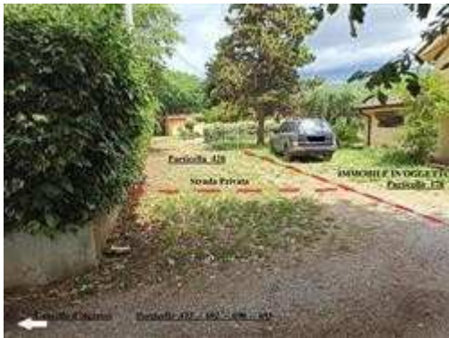
Zona antistante il cancello d'ingresso con indicazione delle particelle catastali
