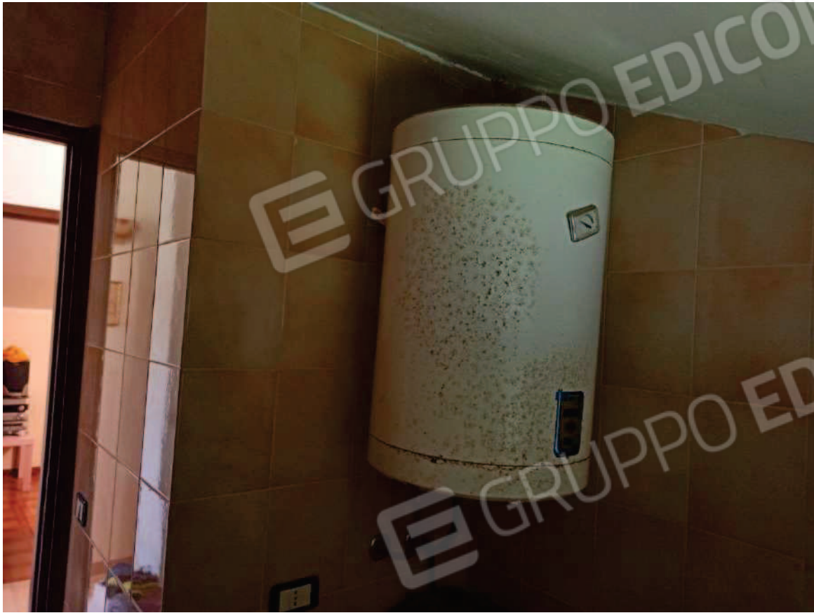
Foto n. 36 – Piano Sottotetto – WC
