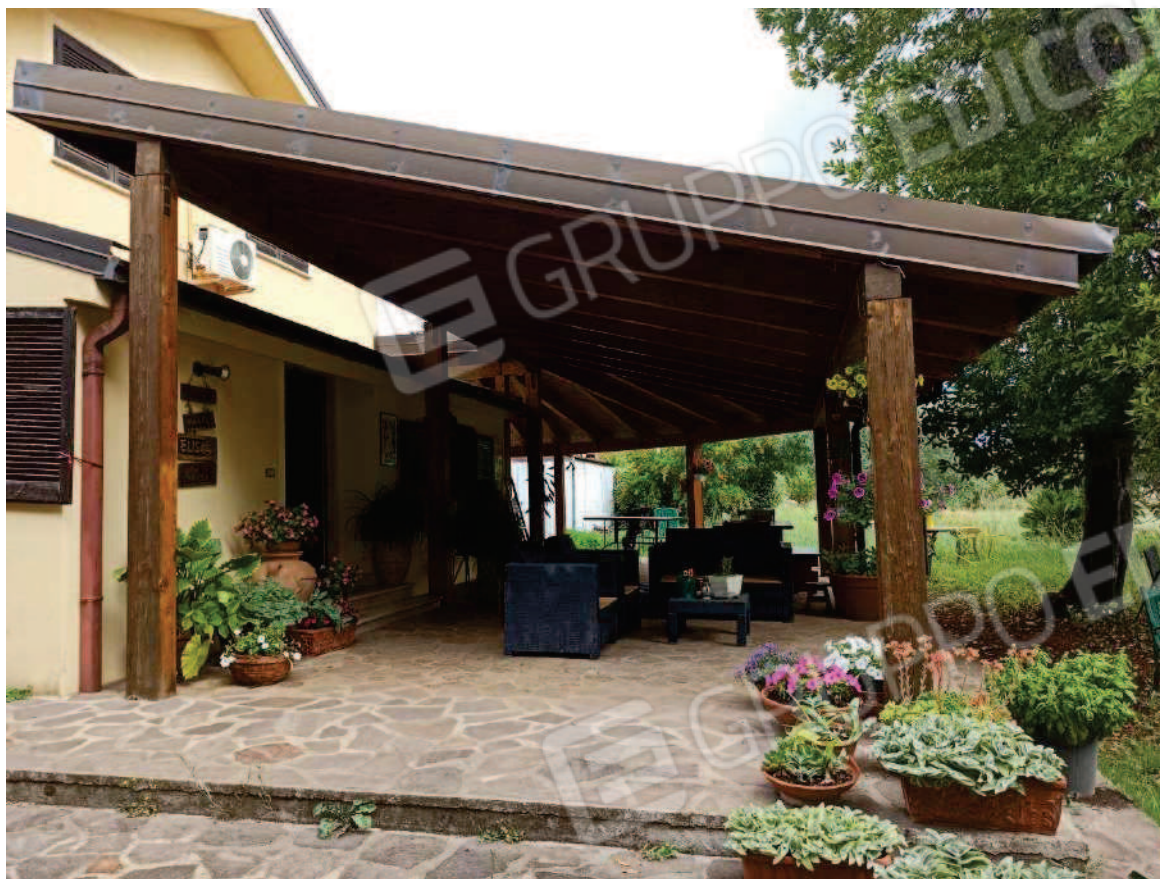
Foto n. 8 – Veduta esterna – Tettoia
