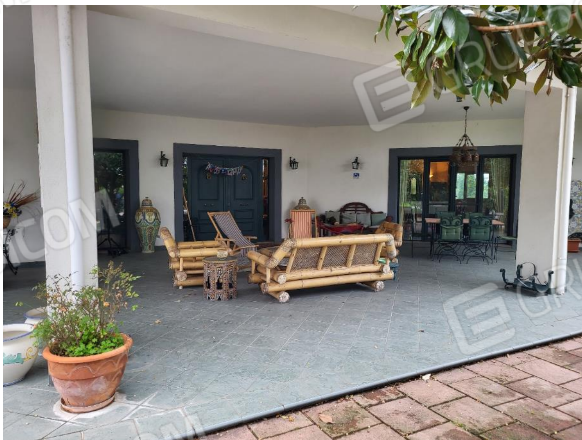
Vista esterna Fabbricato-2
