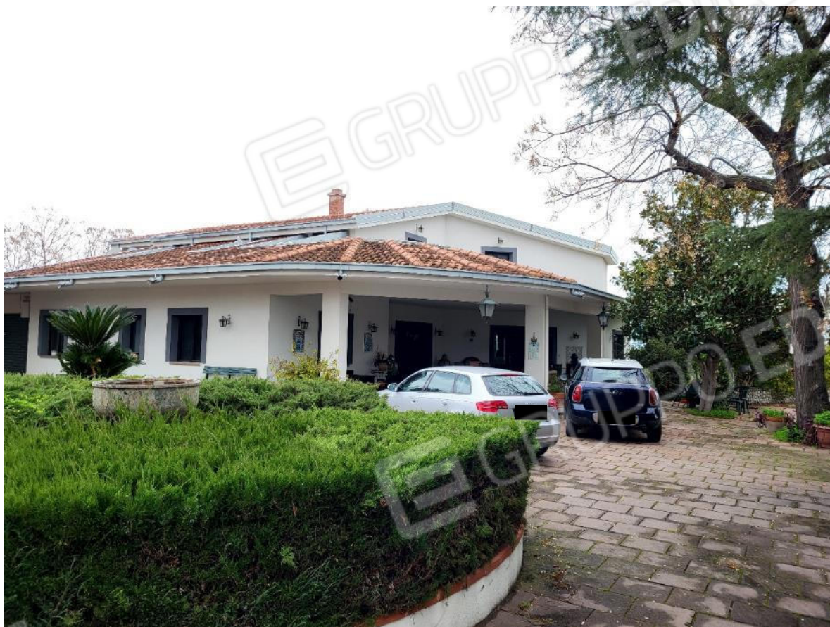
Vista esterna Fabbricato-1
