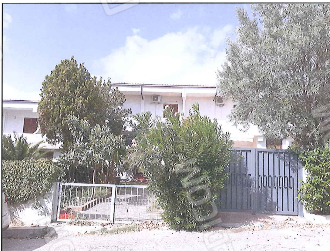
Foto 24. Vista esterna lato est ingresso, con strada e altre unità immobiliari confinanti
