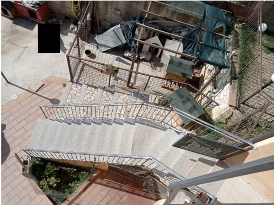
SCALA DI ACCESSO AL PIANO TERRA ESTERNA
