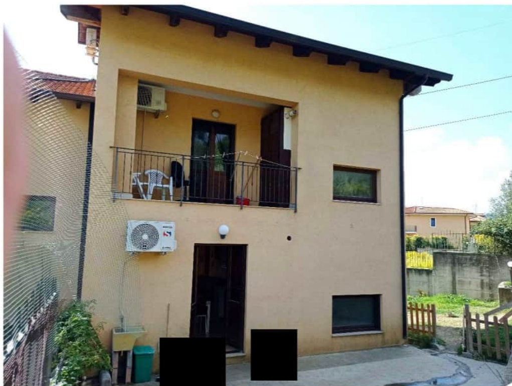
VISTA PROSPETTO POSTERIORE
