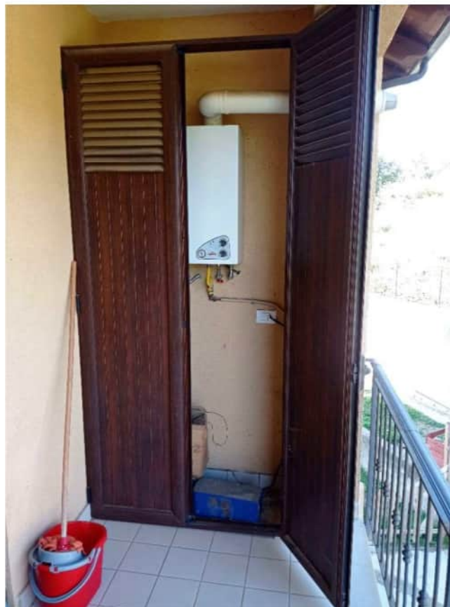
BALCONE ESTERNO PIANO PRIMO
