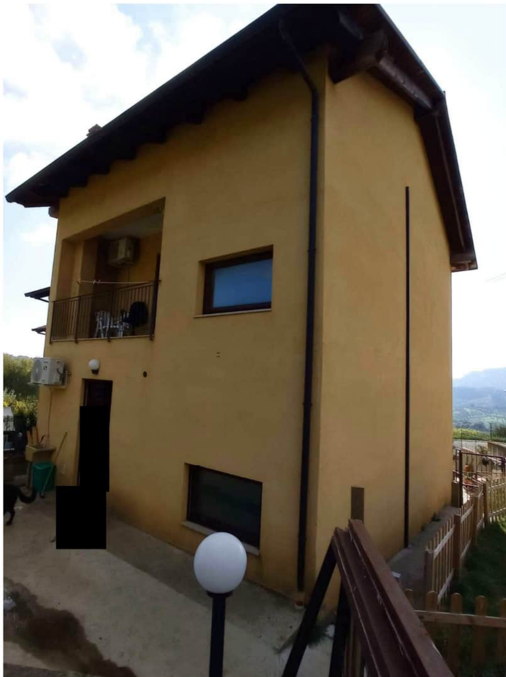
VISTA SCORCIO PROSPETTO POSTERIORE
